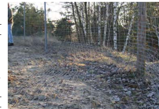
Unterwühlschutz mit Knotengeflecht am Boden
